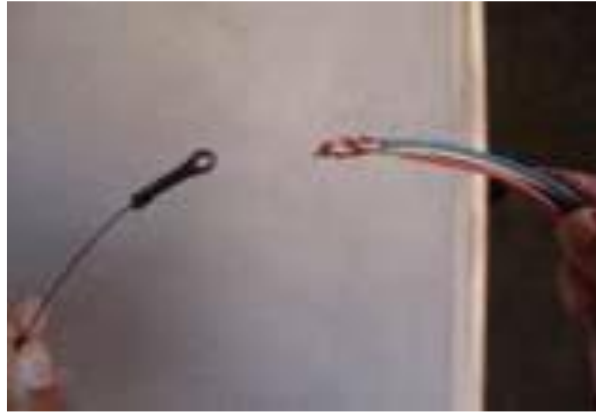
شكل رقم ١٥٣: ادخال الأسلاك في حلقة سوستة سحب الأسلاك
