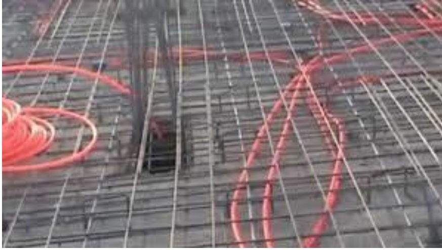
شكل رقم ٨٣: صورة توضح تجهيز المواسير
