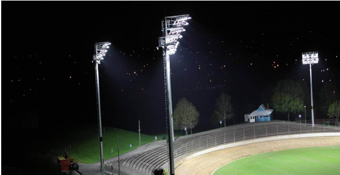
شكل رقم ٦١: اضاءة الملاعب عن طريق الهاليد المعدني
