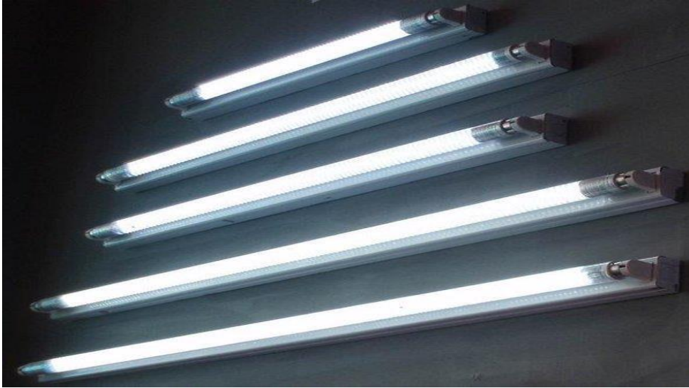
شكل رقم ٥٣: تركيب المصباح الفلوريسنت الطويل (النيون)
