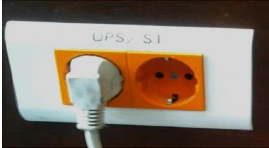
شكل رقم ٩٤: مقبس UPS مزدوج
