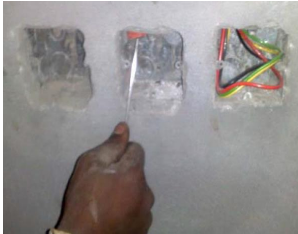
شكل رقم ١٥٥: سحب السلك عن طريق السوستة
