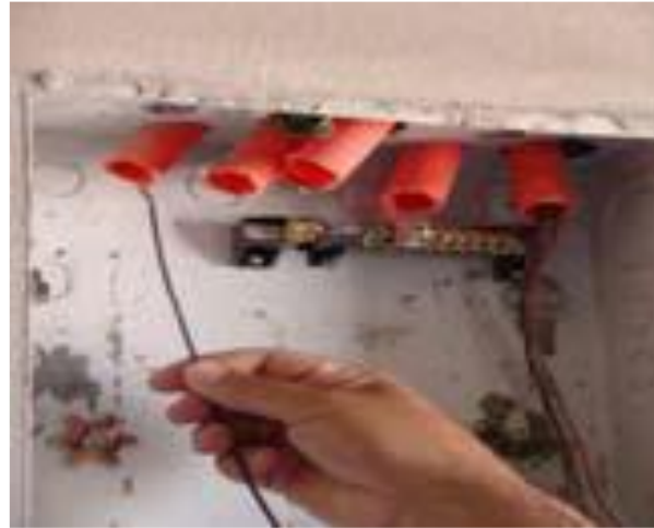
شكل رقم ١٥٢: وضع رأس سوستة سحب السلك في الماسورة البلاستيك
